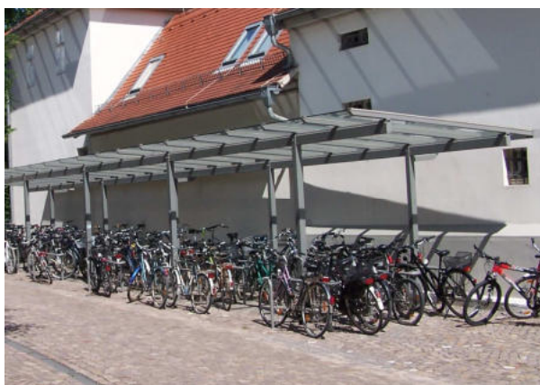
Überdachung einer Abstellanlage in Jena
